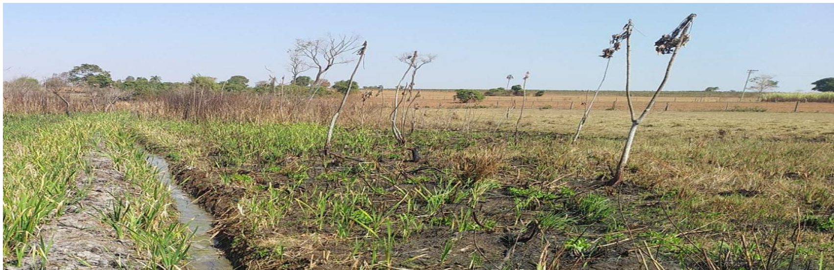
Equipe foi atender denúncia Construção de dreno em área de APP em Santa Mercedes
