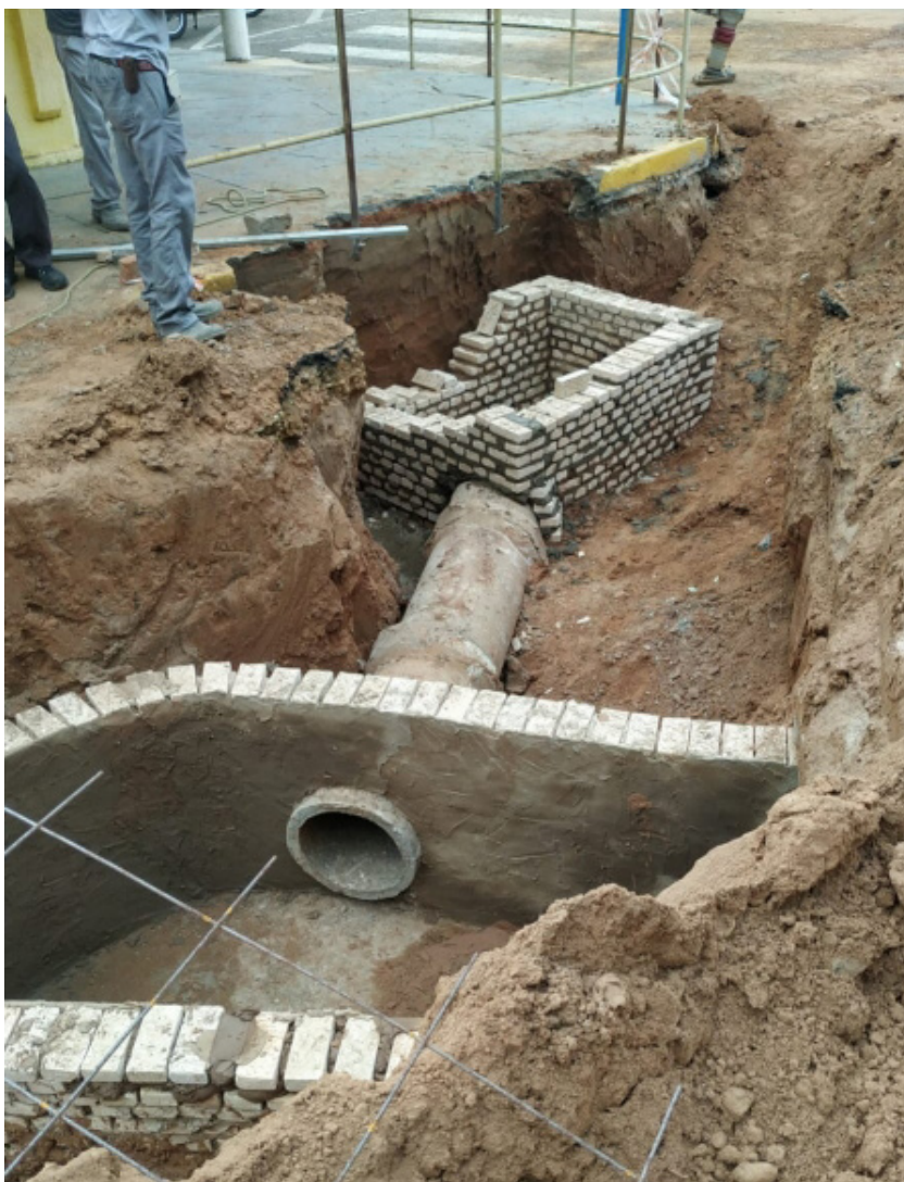
As obras de construção da nova galeria de captação de águas pluviais na Avenida Presidente Roosevelt com a Rua Marechal Rondon
