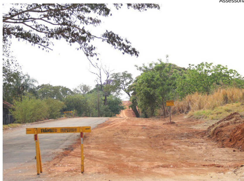
Começou o serviço de abertura do prolongamento da Alameda Inglaterra
