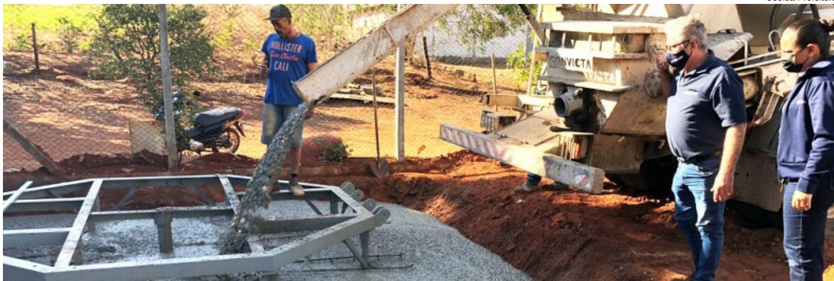
Vice-prefeito Guido Francisco Baggio, presidente da EMDAEP observa a concretagem
