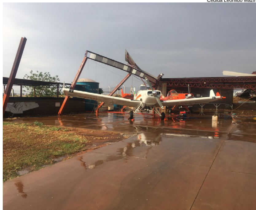
O vento destruiu a cobertura de um dos dois hangares
