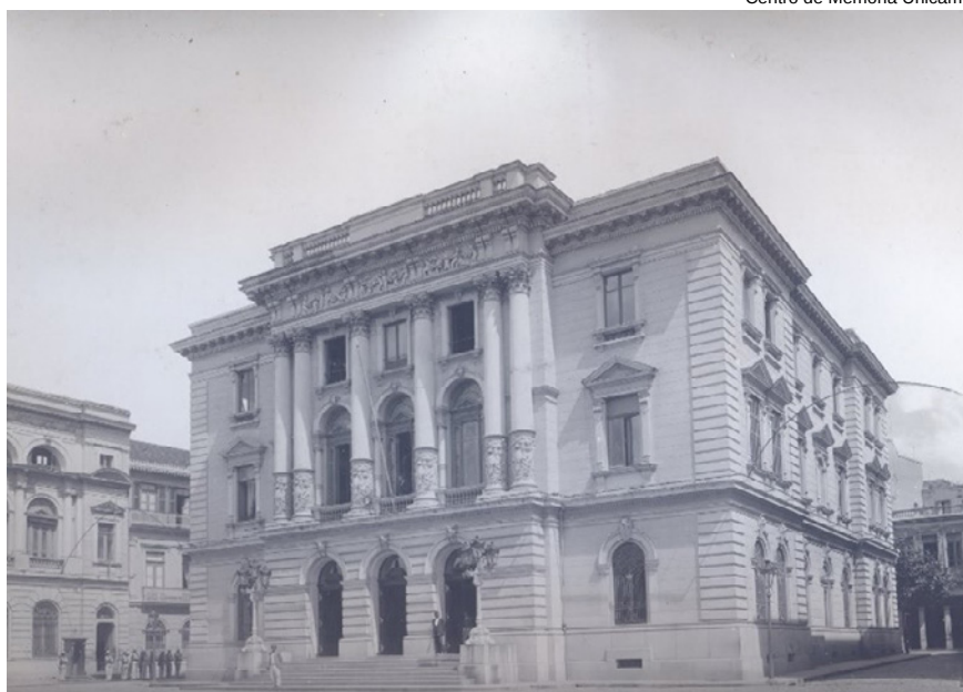
Primeira sede da Secretaria de Agricultura, Comercio e Obras Públicas, a partir de 1896. Atualmente, o edifício é sede da Secretaria de Justiça
