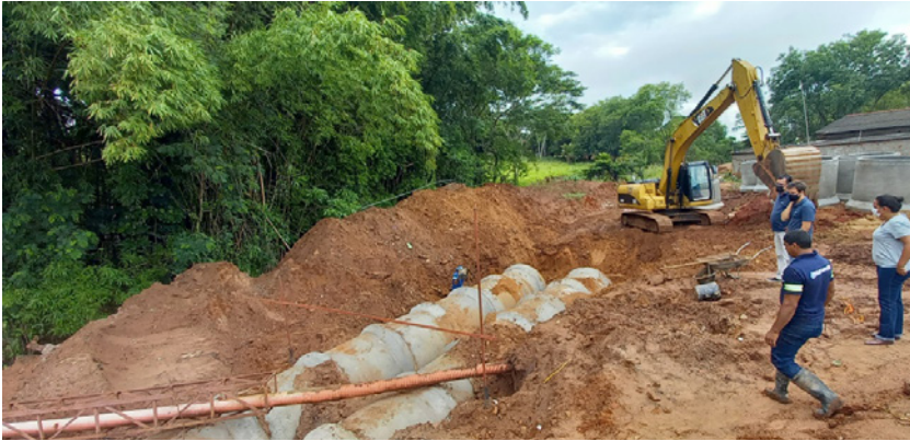
Obras no local chamam atenção
