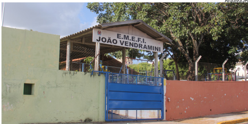
O acesso será pela Rua Vendramini
