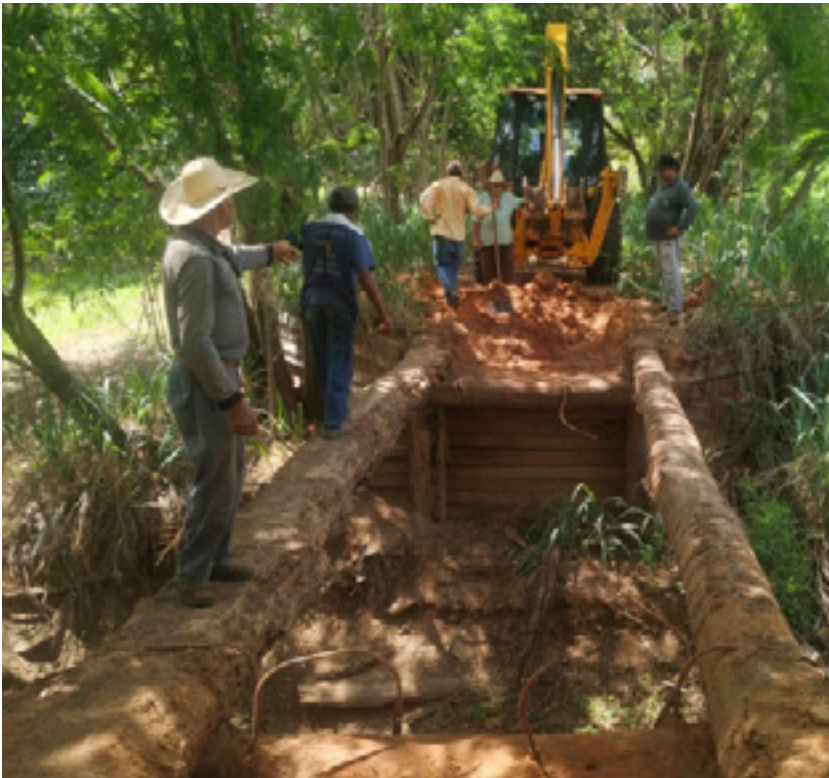
Ponte na DRA - 450 está interditada para reforma
