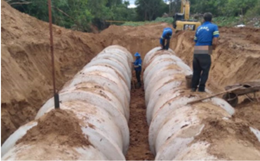
A obra já utilizou cerca de 130 tubos de concreto
