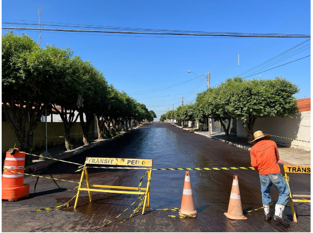
Trechos de ruas recapeadas em vários pontos da cidade
