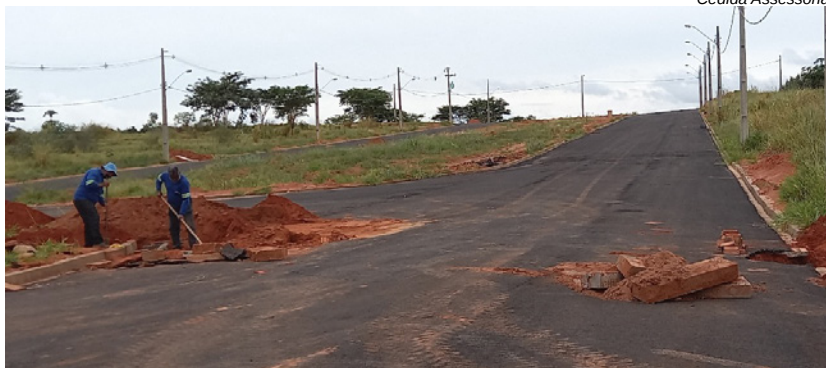
Equipe da Emdaep trabalha no Distrito Comercial
