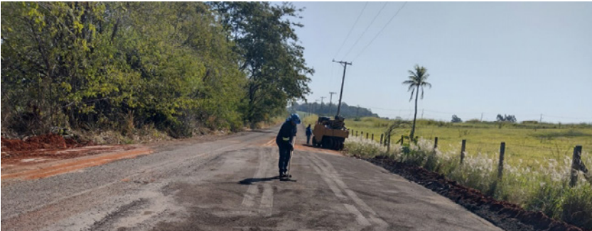
O trecho recebeu pintura de ligação, revestimento e compactação
