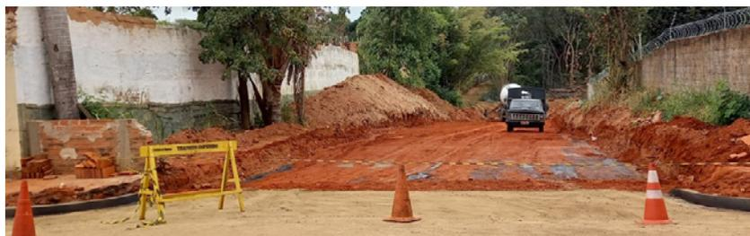
Estão sendo finalizados os serviços da galeria da Rua Ipiranga, com a construção de caixas de captação e concretagem do poço de vistoria
