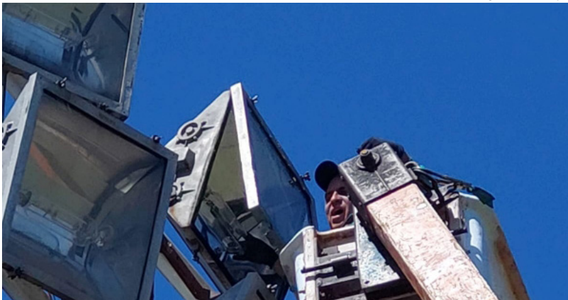
INSTALAÇÃO DE NOVAS LÂMPADAS DE VAPOR METÁLICO
