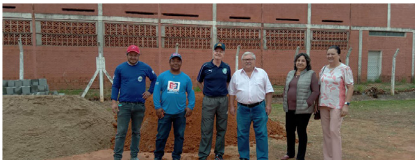
A construção da sala foi iniciada
