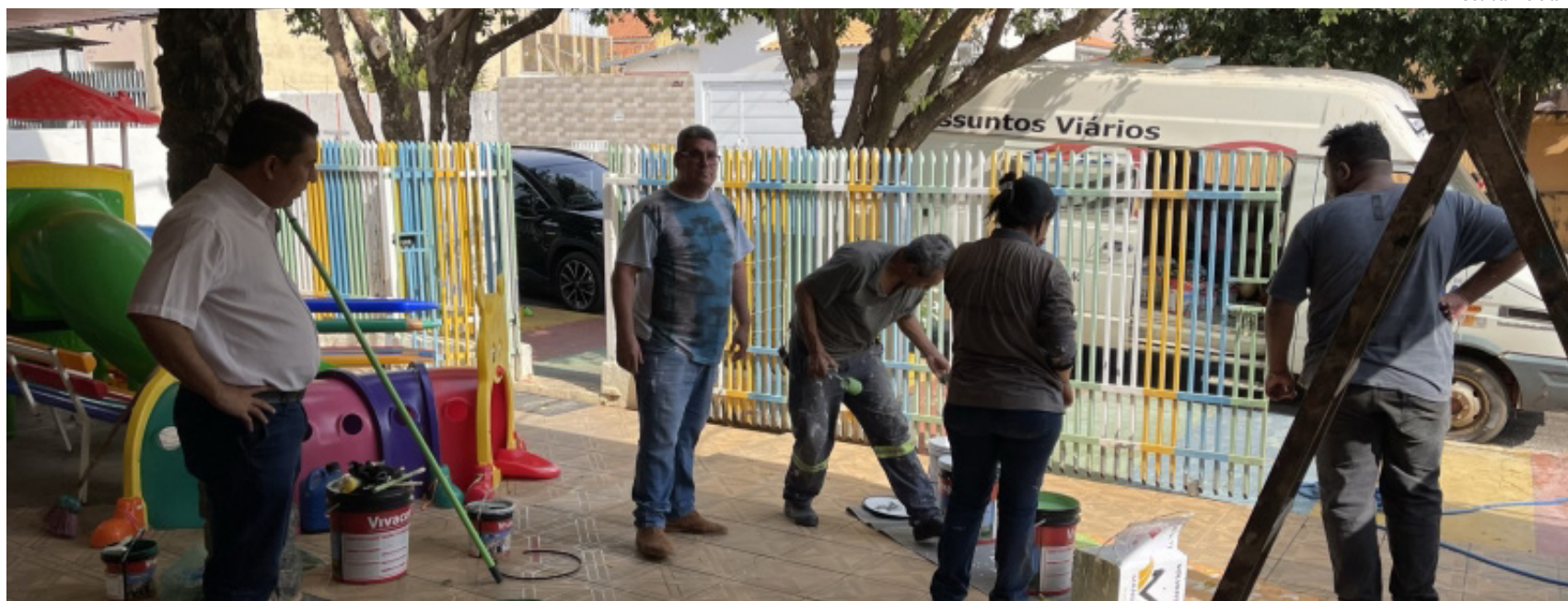
Escola EMEI Sossego da Mamãe recebe manutenção e adequações
