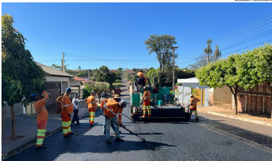
Execução do recapeamento durante esta semana
