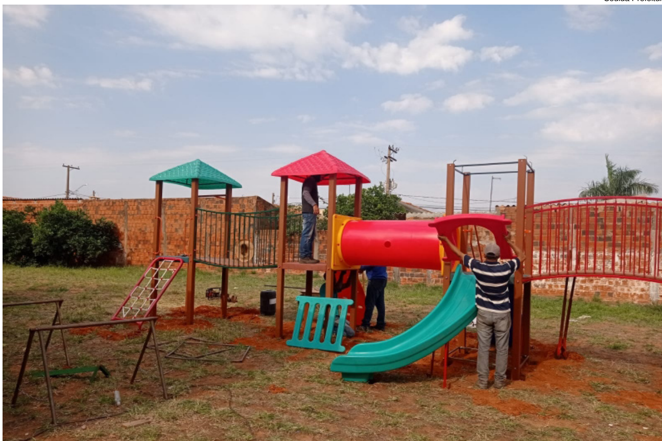
No conjunto Paulo Vendramini também estava sendo montado um parquinho
