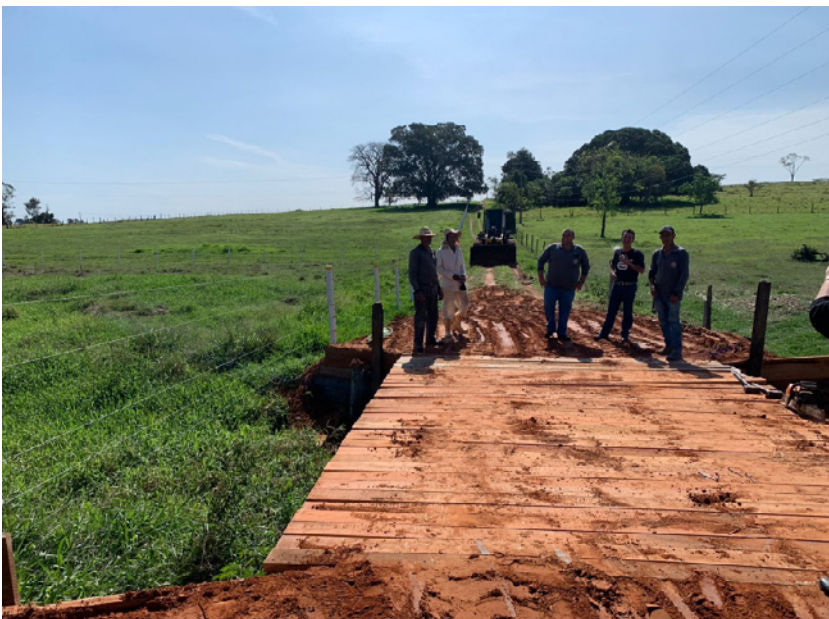
Ponte no Bairro Marrecas
