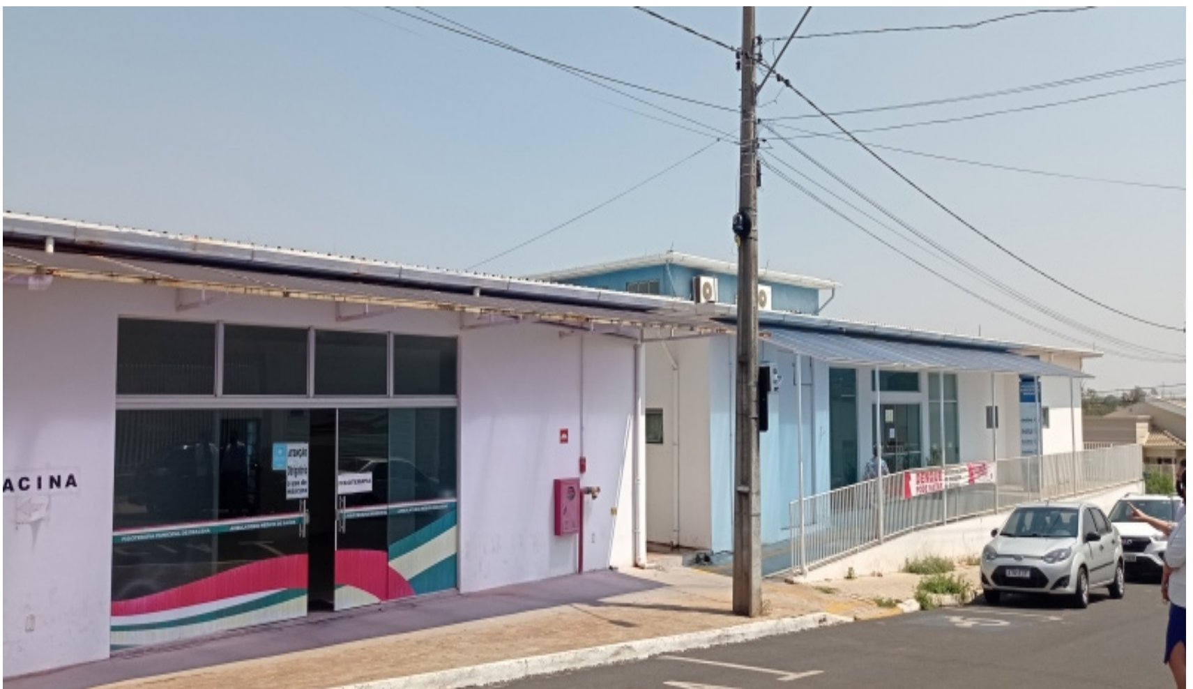
Policlínica Municipal - Bairro São Cristóvão
