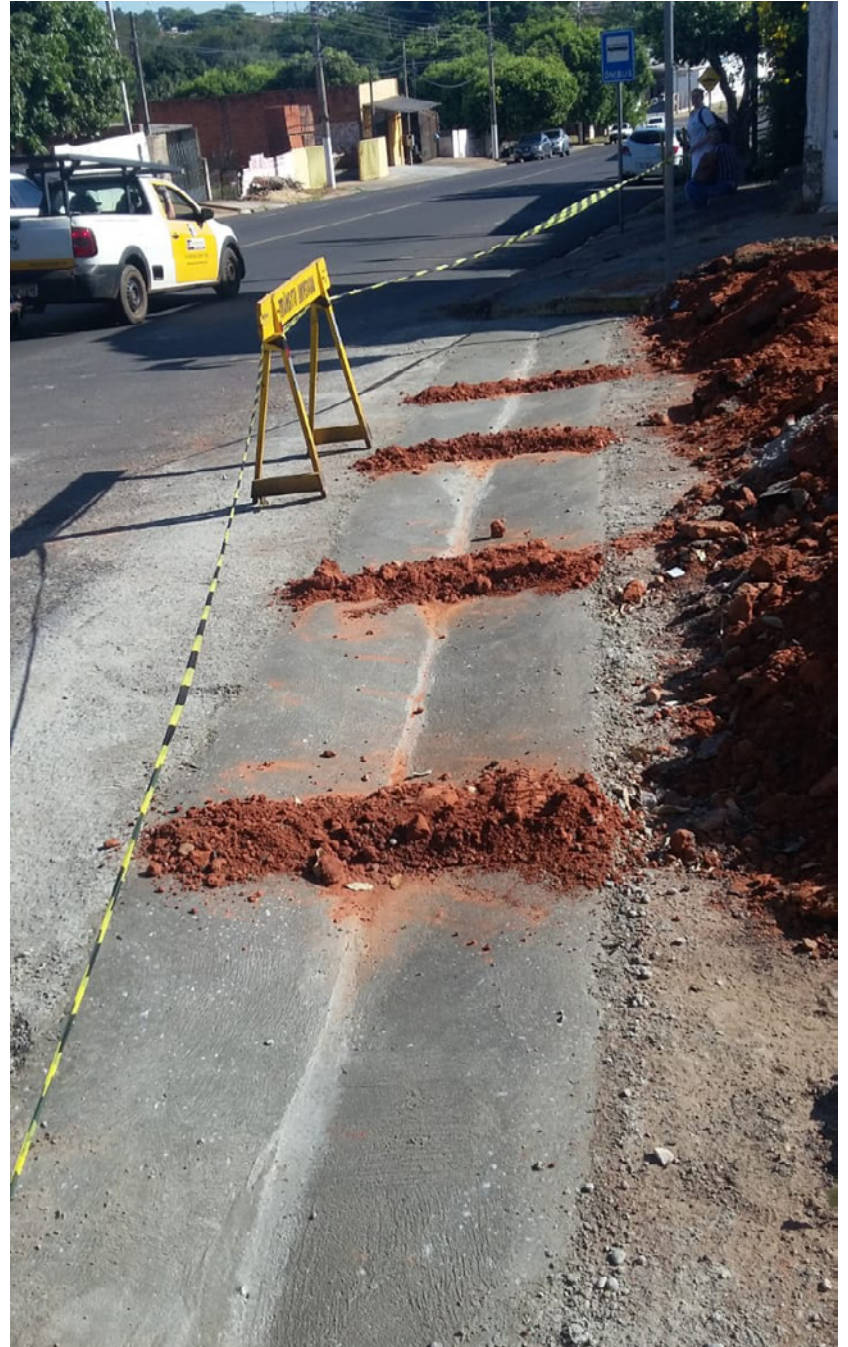
Sarjetões em construção em pontos da cidade
