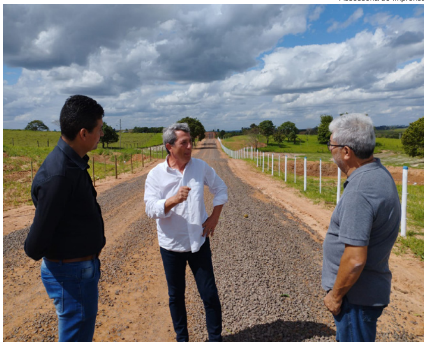
Pinatto e diretores vistoriam a obra de reconstrução da estrada rural
