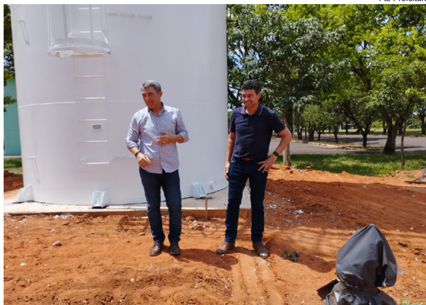
Acoplado o reservatório e o poço começam funcionar em fevereiro
