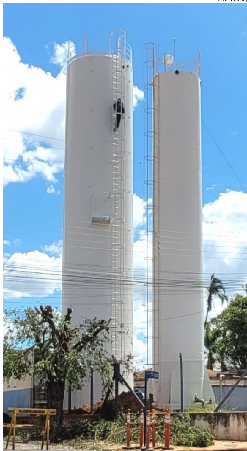
O novo reservatório instalado junto ao poço no bairro São Francisco
