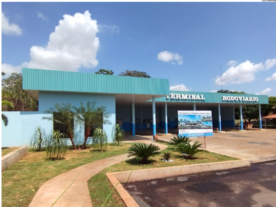
Terminal Rodoviário de Junqueirópolis, obra em conclusão
