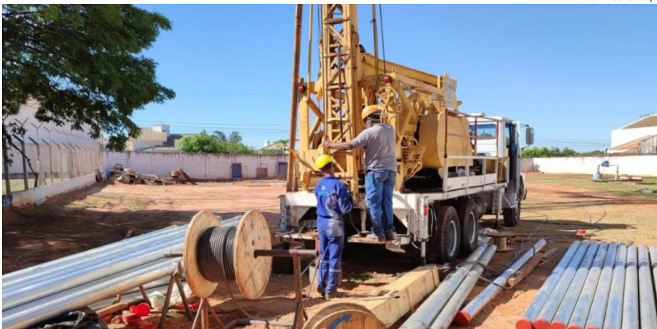
Instalação da bomba no poço da alameda Inglaterra
