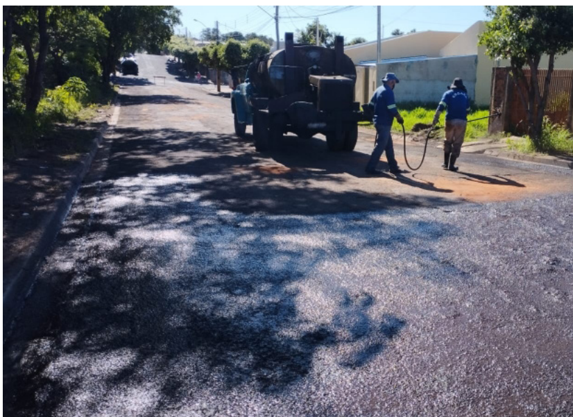
Serviços são executados na rua Spinardi
