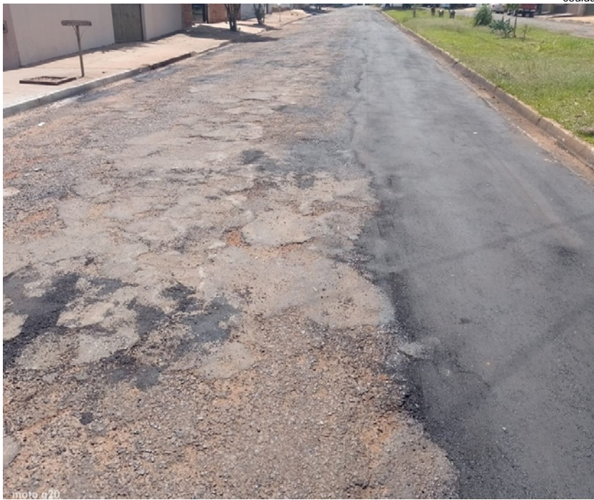
Obras na avenida Milton Noronha Gustavo
