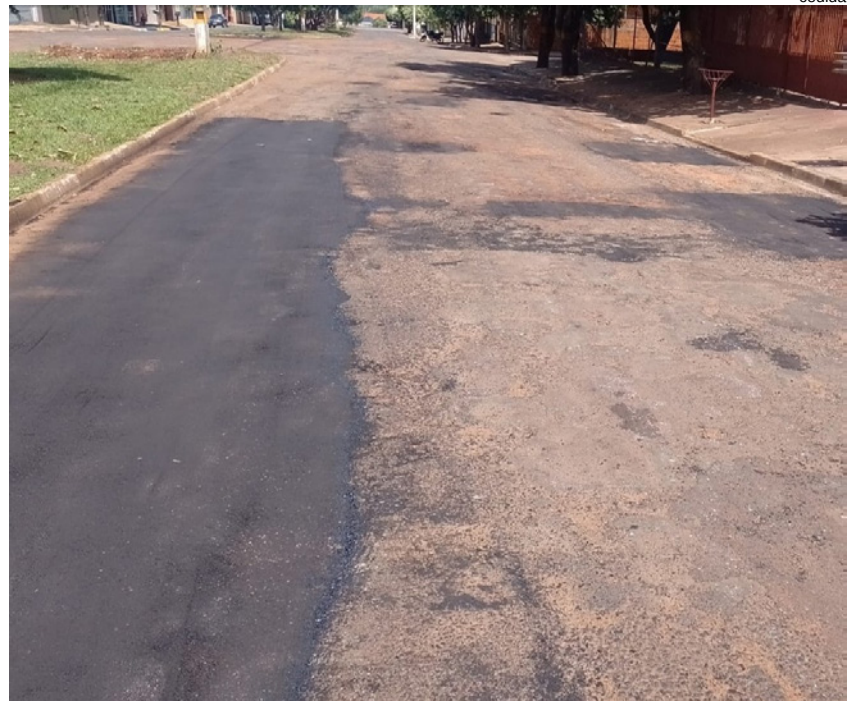
Correção para em seguida iniciar o recape
