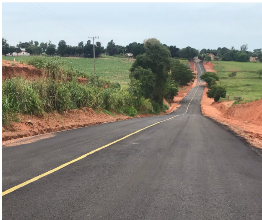
O trecho que será asfaltado tem 10,4 km
