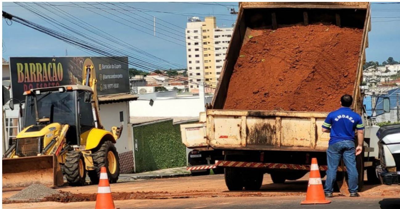
Implantação da instalação da nova rede de água e ramais na rua Euclides da Cunha
