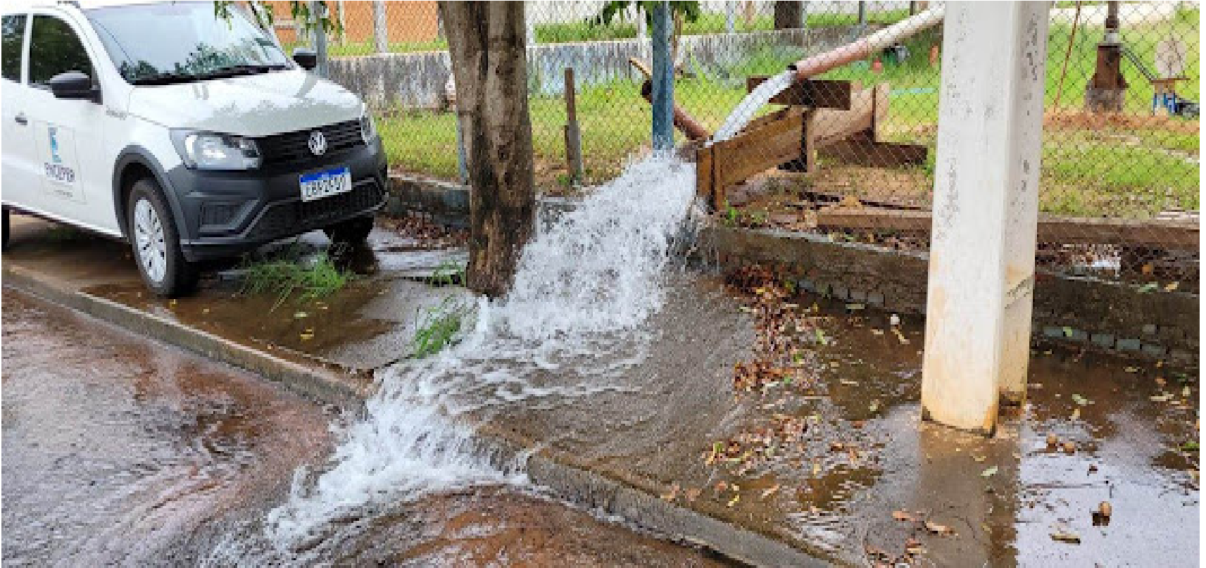
Serviços em execução na alameda Inglaterra
