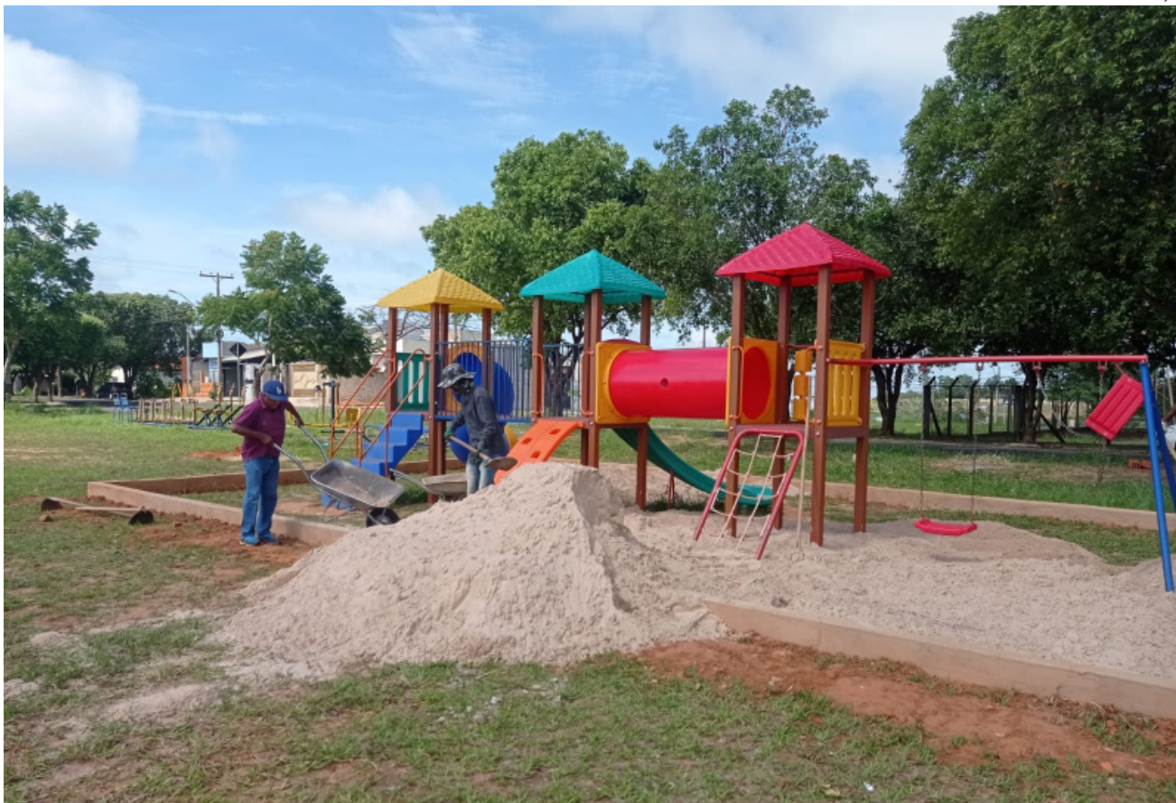
Instalação de playground em praça de Dracena
