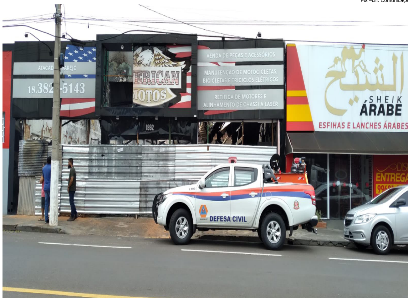
Prédio pegou fogo na madrugada de segunda-feira (2), no centro de Dracena
