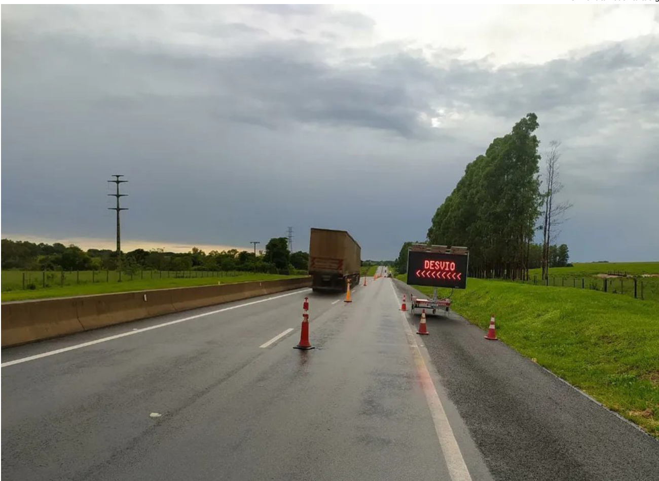
Trânsito segue com desvios no local atingido pela enxurrada de terra e detritos
