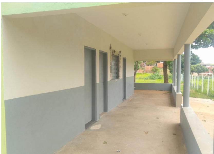
Pintura do novo vestiário está em fase de conclusão
