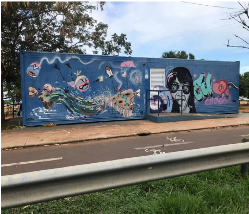
Segundo a Polícia o homem teria sido atingido por uma descarga elétrica ao entrar no contêiner
