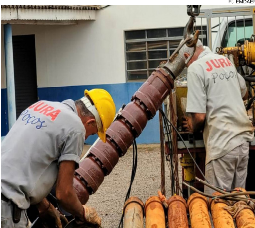
Instalação da nova bomba no poço na manhã desta quarta-feira
