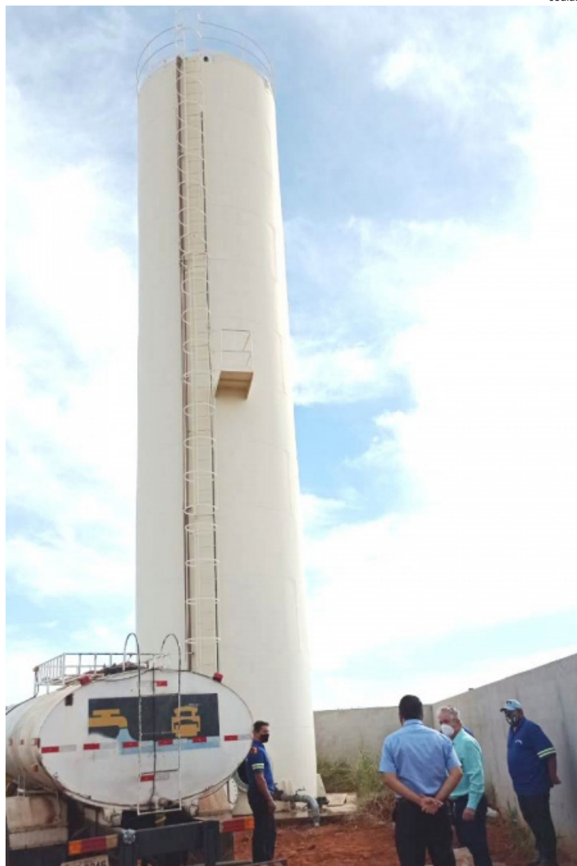
Imagem do reservatório do conjunto João Vendramin
