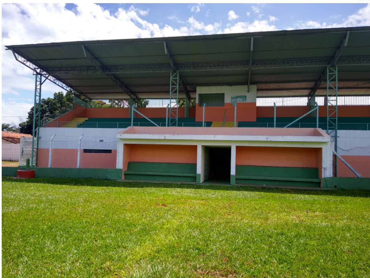
Além da nova pintura foram realizadas diversas melhorias
