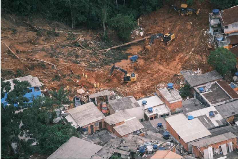
Danos causados pelas chuvas no Litoral Norte
