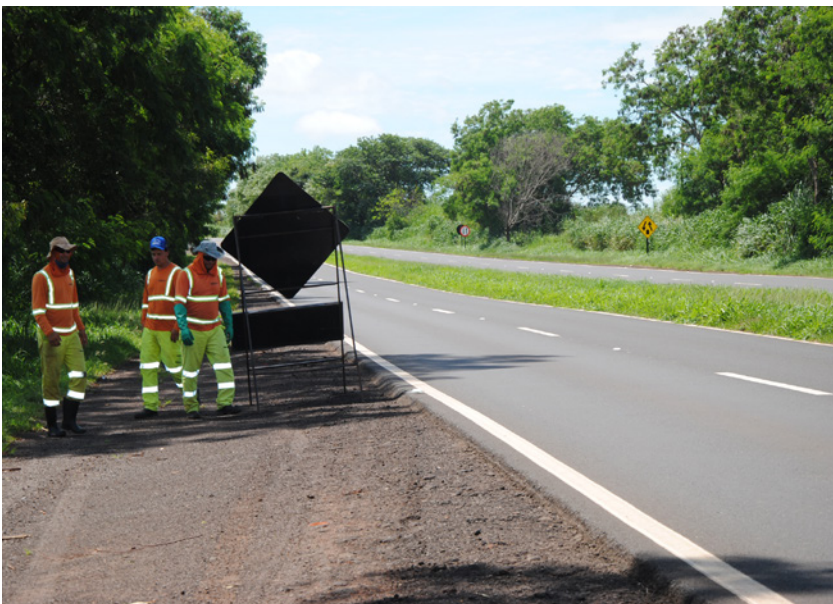
Obras na pista da SP-294 na manhã desta quinta-feira
