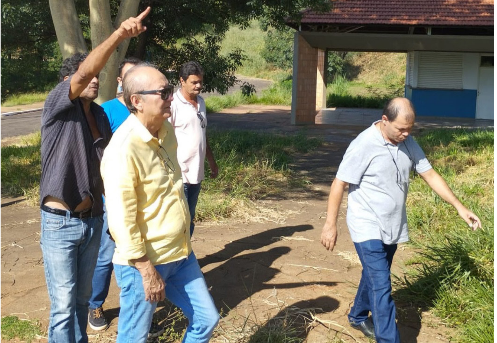
Prefeito Dr. Carlos em vistoria ao Balneário Municipal após danos das chuvas
