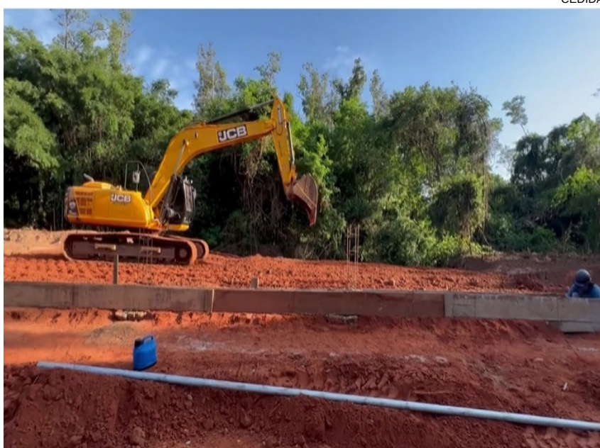
Obras estão em ritmo acelerado
