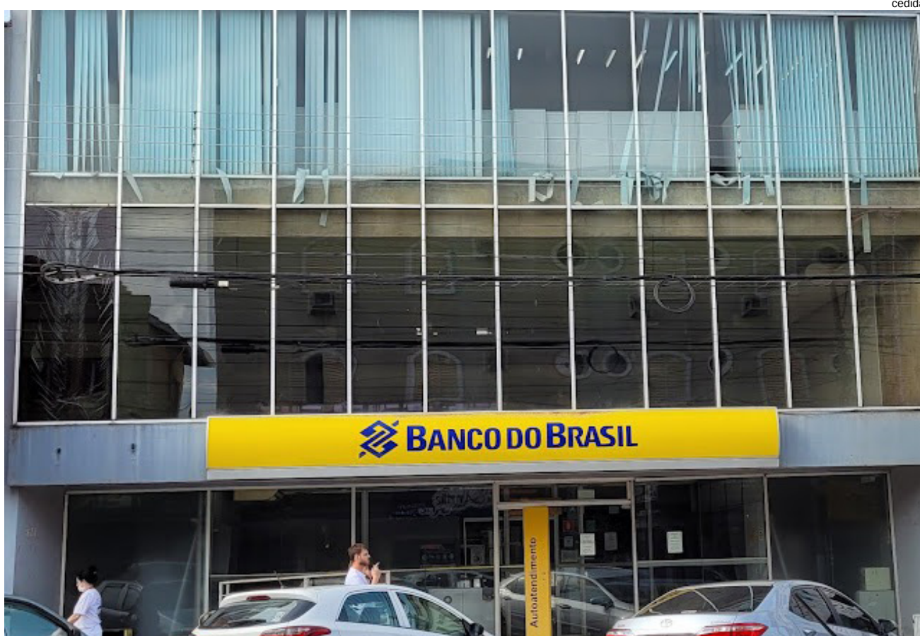
Prédio sem atividades atualmente
