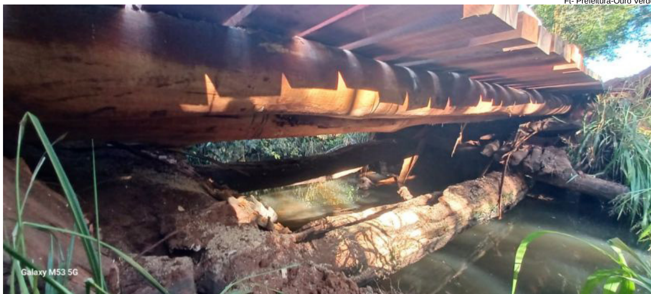
Ponte danificada pelas fortes chuvas de março foi reconstruída
