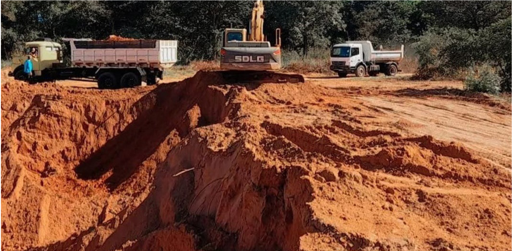
Maquinários da Prefeitura executam obras do bacião no bairro Areia Branca
