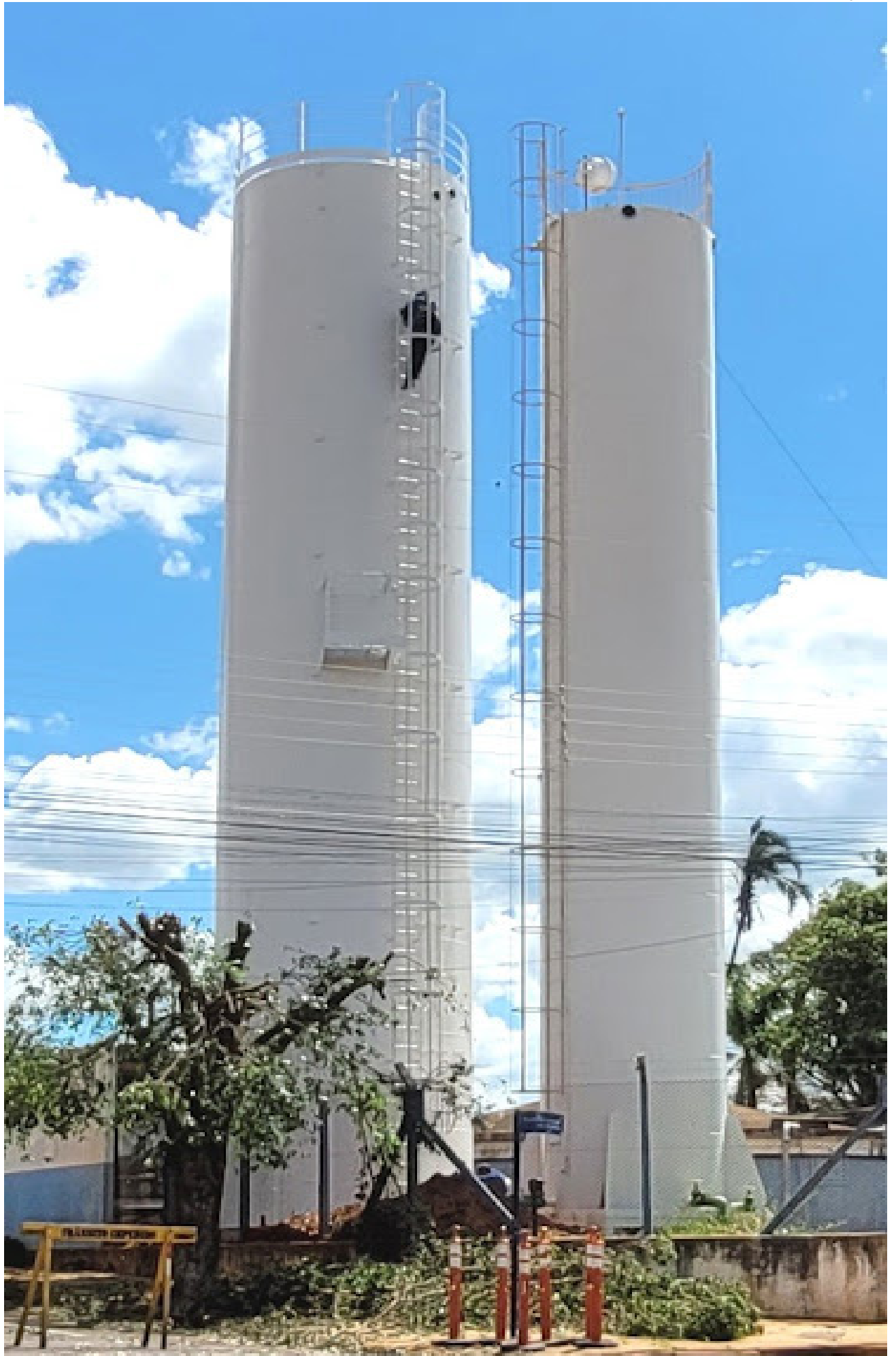
Limpeza dos dois reservatórios do bairro São Francisco ocorre neste sábado, 20
