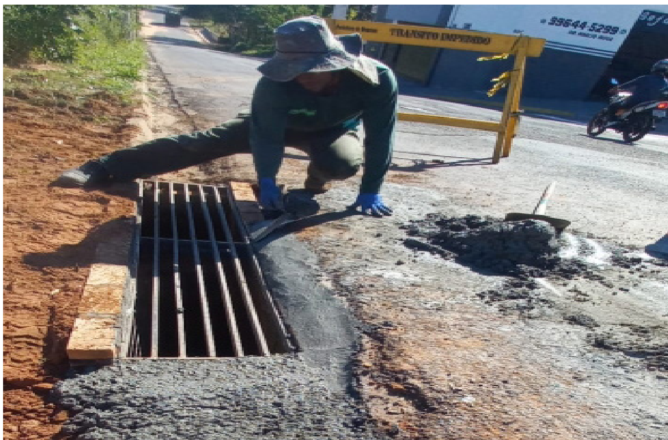
Boca de lobo que estava danificada na passagem do Village para o Fioravante foi arrumada
