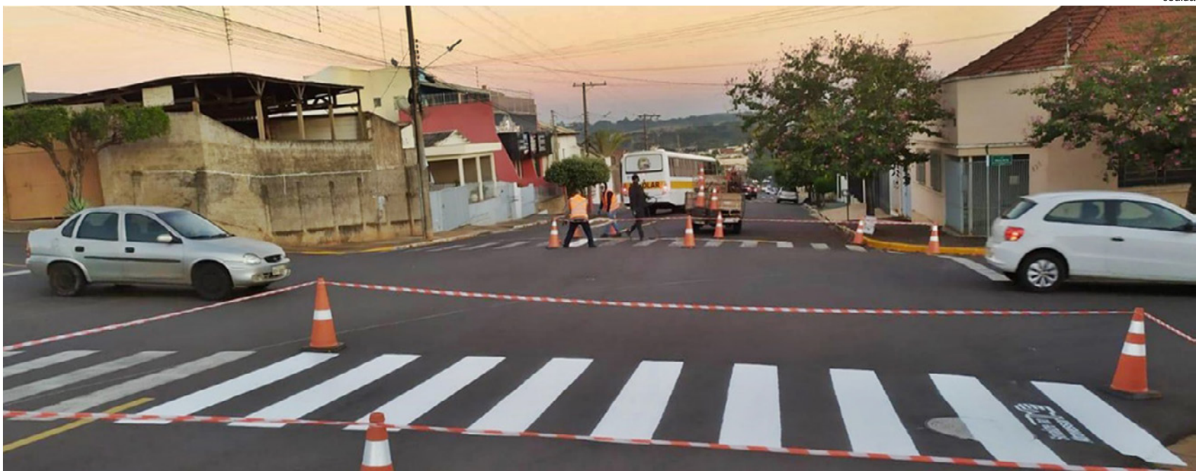
Serviços de pintura de nova sinalização de solo na avenida
