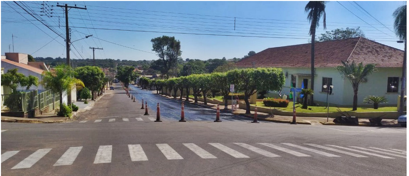
Recapeamento da avenida Junqueira, em Junqueirópolis
