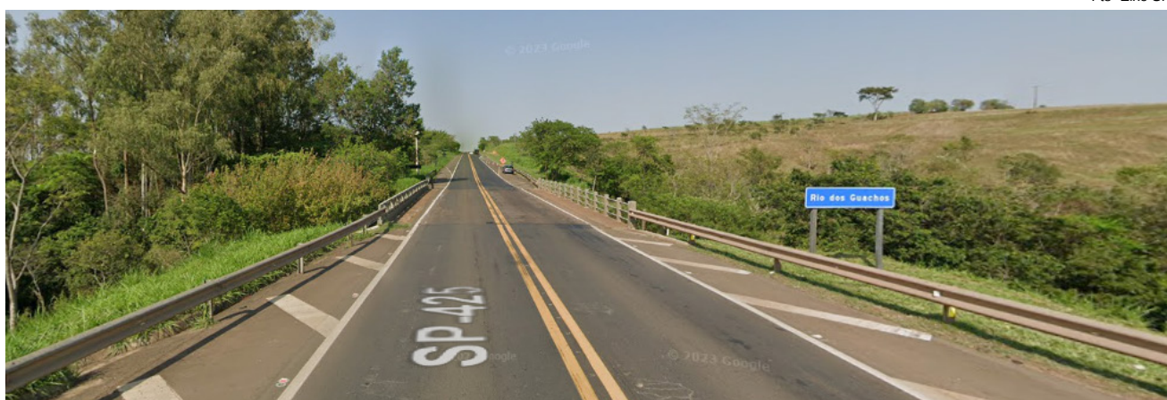
Ponte onde será realizada a obra na SP-425, trecho Martinópolis-Parapuã
